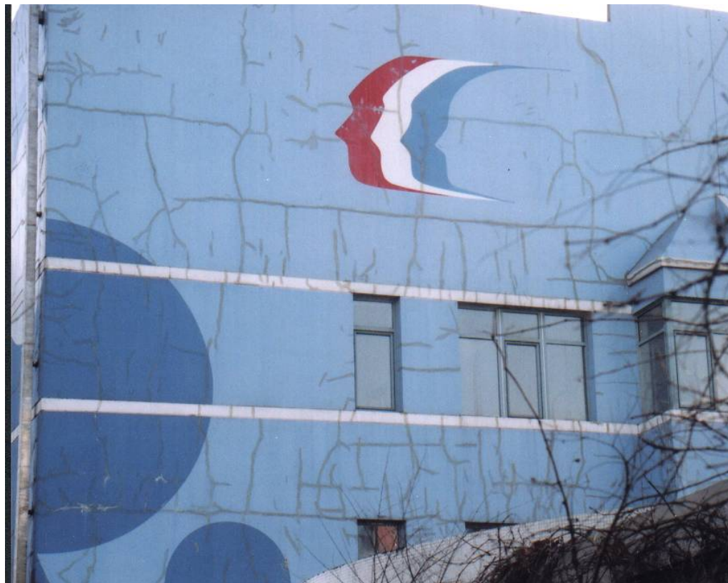
膨胀聚苯板薄抹灰基面
