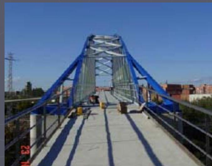
2001年10月，在西班牙Lleida市以南3KM处，修建了一座穿过一条公路，一条铁路和新计划的马德里和巴塞罗那间的一条高速铁路的人行桥。桥身是全GFRP拉挤成型的型材修建的桁架。跨度38米，矢高6.2米。（矢跨比大约为6），宽3m。桥总重约为19吨。这座桥是世界上用玻璃纤维材料修建的最长的拱桥。所有的截面都是使用无碱玻璃纤维和机织复合衬垫制作的，玻璃纤维的最小含量为50%，胶结材料为异酞聚合物。
