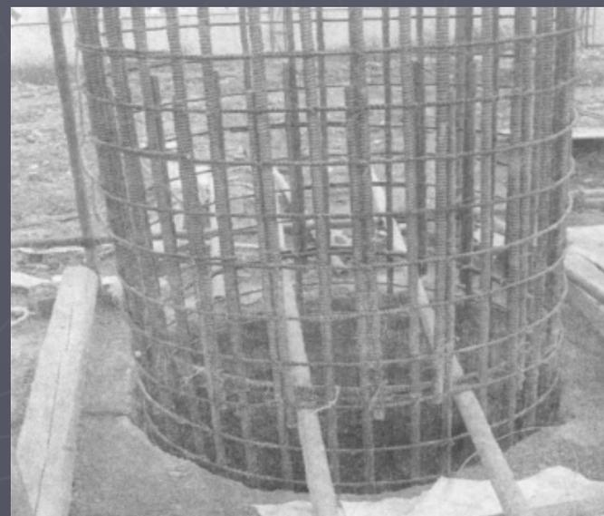
用GFRP筋代替盾构围护结构中的钢筋,不但保证了盾构井围护结构的安全,而且使盾构始发、到达施工时不需要人工破除洞门,减少了盾构施工的安全风险。
