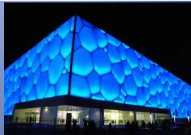
“水立方”防护工程
