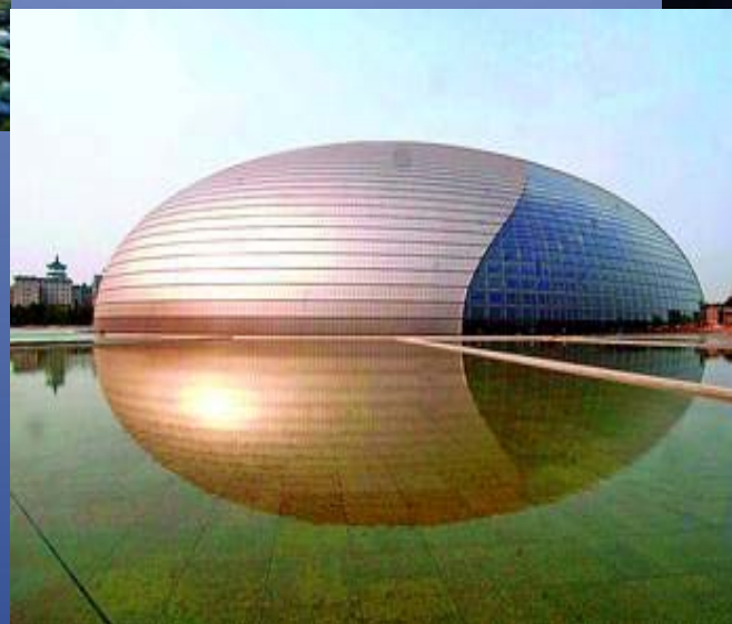
国家大剧院景观水池防水工程
