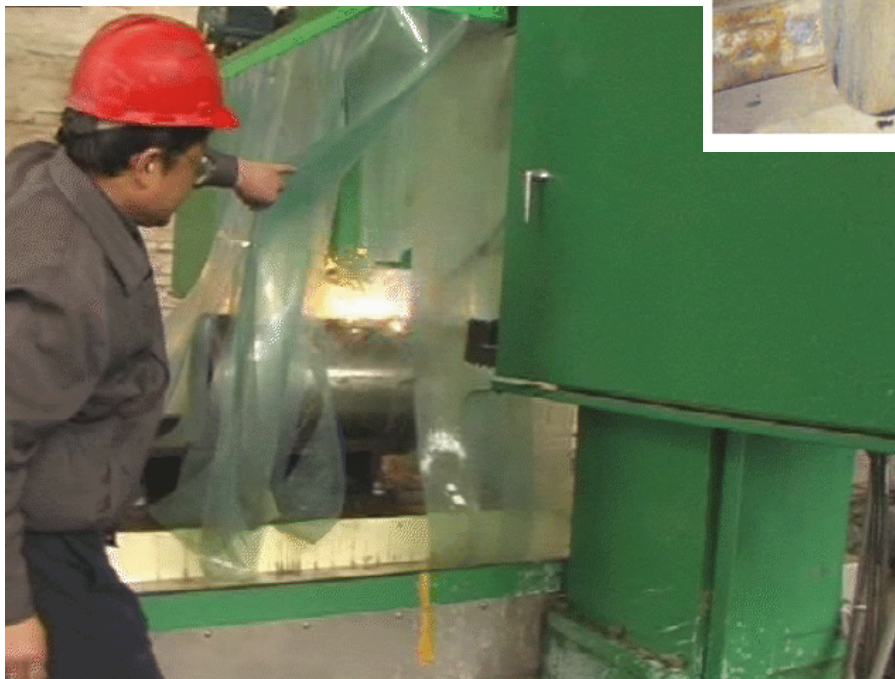
正在切割加工
