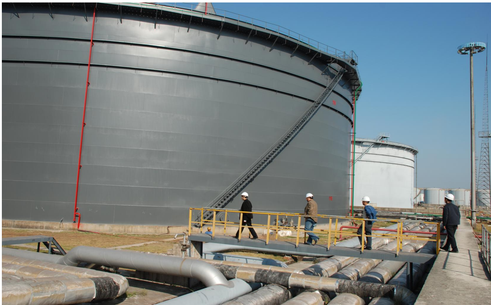
茂名石化116#原油罐
