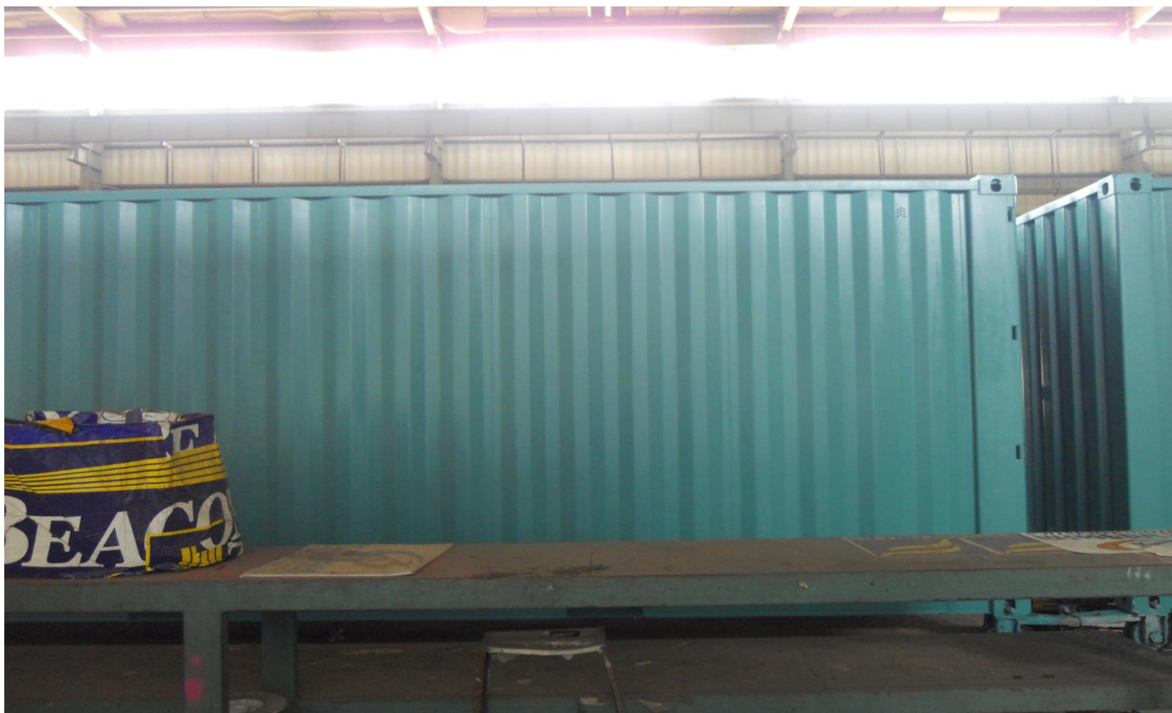
产品在广州南沙东方国际集装箱厂的涂装施工
