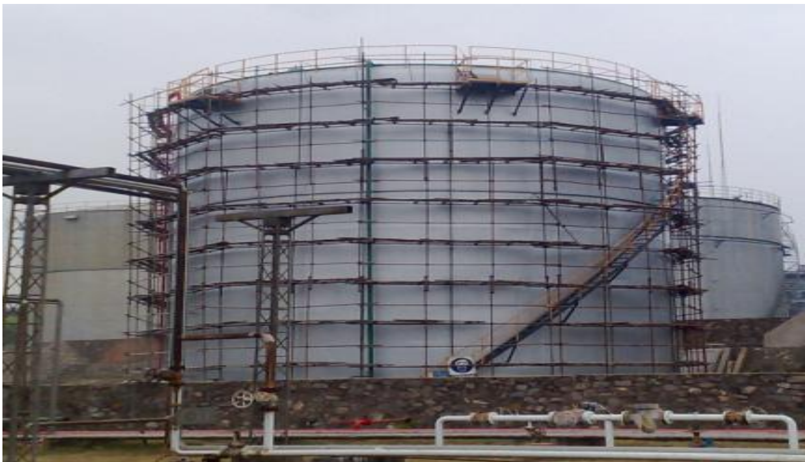
茂名石化804#油罐内壁导静电防腐蚀涂料涂装施工
