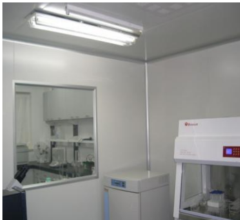
生物材料医用净化室
