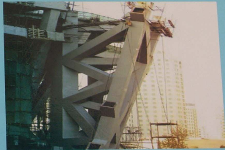
组装中的钢结构
