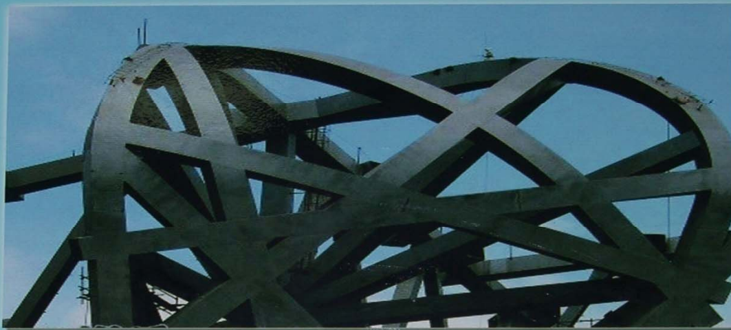
鸟巢建筑工程中的箱形构件
